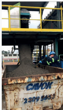
Operario distribuyendo el lodo
