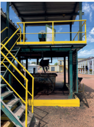
Zona de proceso de centrifugado.
